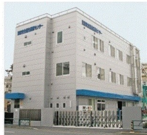
(公社)東基連 安全衛生研修センター(別館) [学科及び実技会場]
