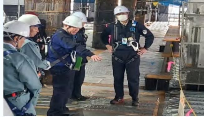
東京労働局長による建設現場パトロール
