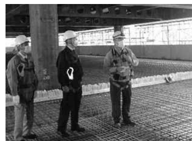
東京労働局長による建設現場パトロール
