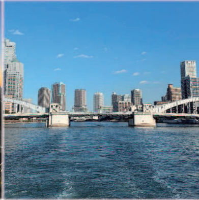
中央区(勝鬃橋)
