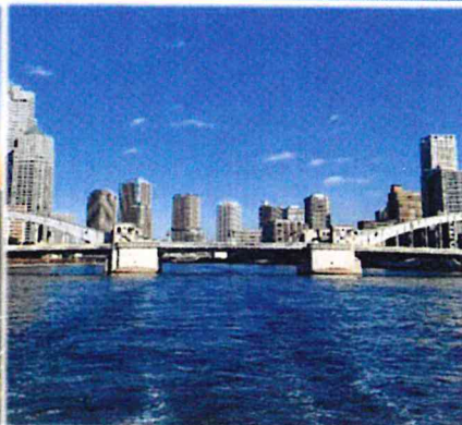
中央区(勝鬃橋)
