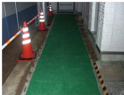
*滑りにくいマットも敷設
