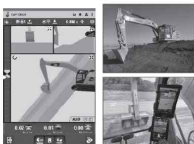
画像1 マシンコントロールによる法面施工
